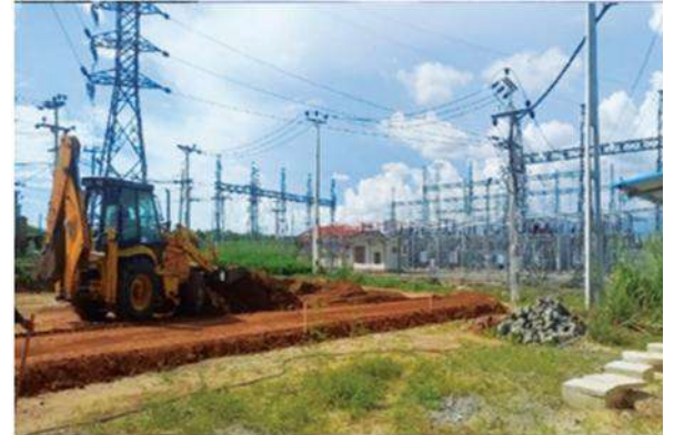
හම්බන්තොට විදුලිබල ජාල උපපොළේ බැටරි බලශක්ති ගබඩා පද්ධතියක් ස්ථාපිත කිරීම (BESS)
